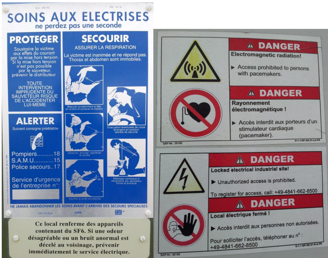
Figure 15 - Panneaux d'avertissement sur les portes des aérogénérateurs et du poste de livraison
