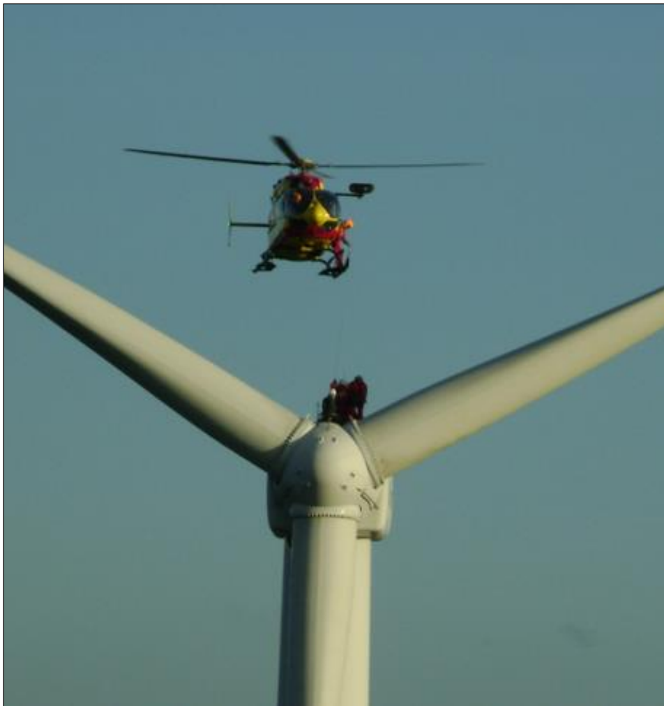
Figure 5 : Exemple d'exercice d'évacuation d'une éolienne Boralex avec le SDIS 43 sur le parc éolien d'Ally (Haute-Loire)
